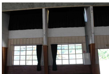
旧体育館木製窓枠
