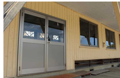
アルミ製窓枠に改修
